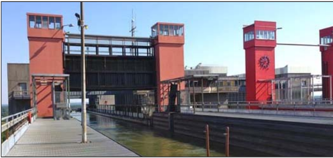
Das größte Schiffshebewerk Europas in Scharnebeck
